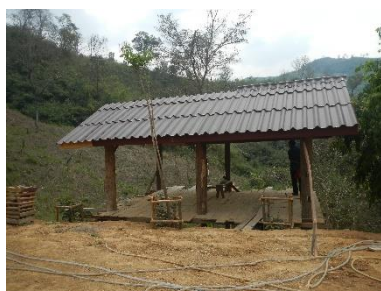
Vom restlichen Baumaterial hat die Gemeinde einen Unterstand gebaut
