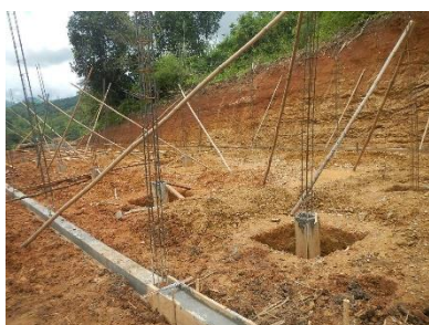
Das Fundament ist gelegt
