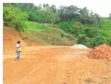
Das Land wurde vom Schulleiter für das neue Schulgebäude vorbereitet
