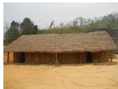
Einige Primarschüler mussten auf dieses Gebäude mit Wänden aus gewobenem Bambus und Strohdach ausweichen
